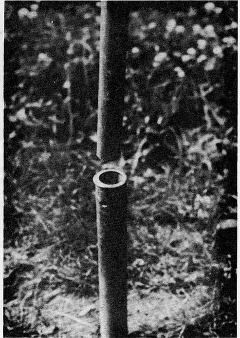
Fig. 2D. Inserción del poste de aluminio a la base una vez que ésta se ha fijado en el suelo.
